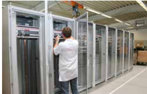
Im Schaltschrankbau fertigen die Trainees eigene Schaltschränke nach Anforderungen realer Projekte.
